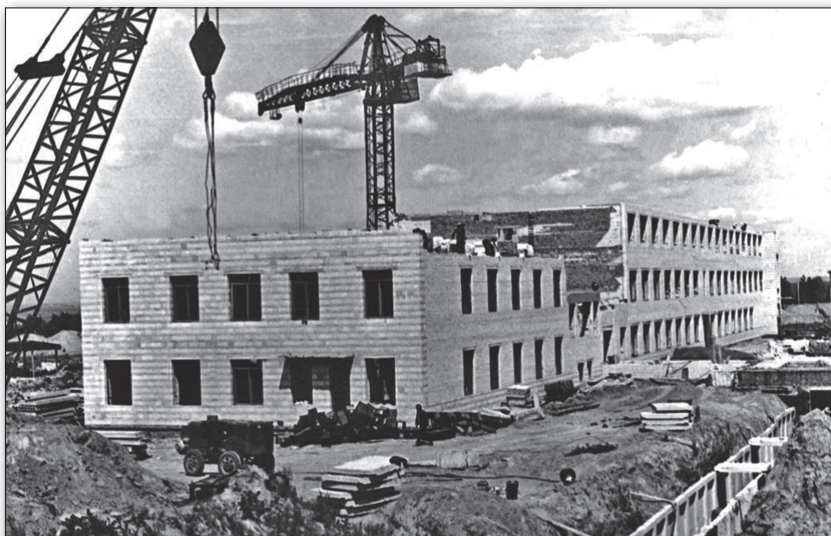
Строительство первого корпуса Института неорганической химии СО АН СССР. Новосибирск, 1958 г. 360
